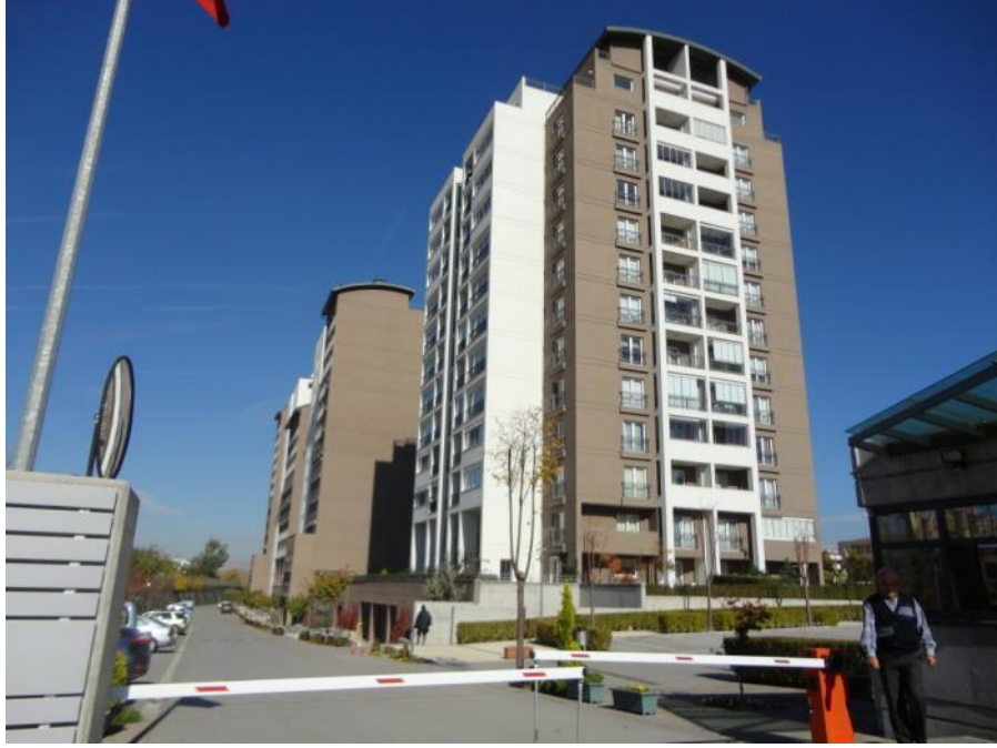
Taşınmazların 2082. Caddeden (Site girişi) görünüşü
