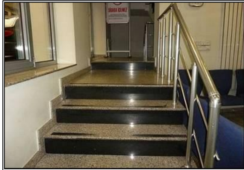
Zemin kattan katlara çıkan ara merdiven
