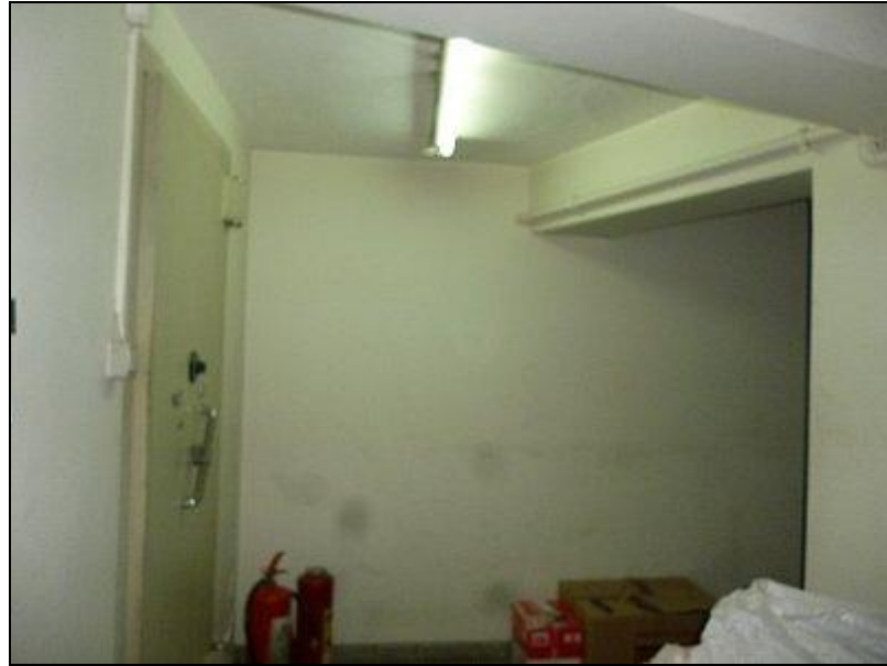
Bodrum kat kasa bölümü
