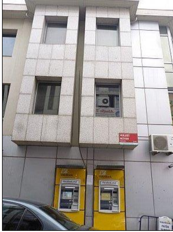
Hulusi Noyan Sokak cephesi bankomatlar
