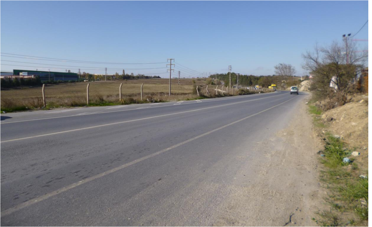
Foto 2. Planlama Alanının Güneydoğudan Görünüşü
