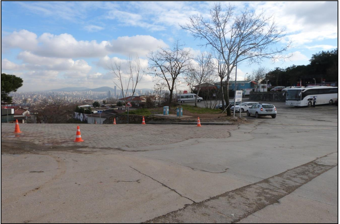
Şekil I.B.1.6 İstanbul Büyükşehir Belediyesi Sosyal Tesisleri Otopark Alanı
