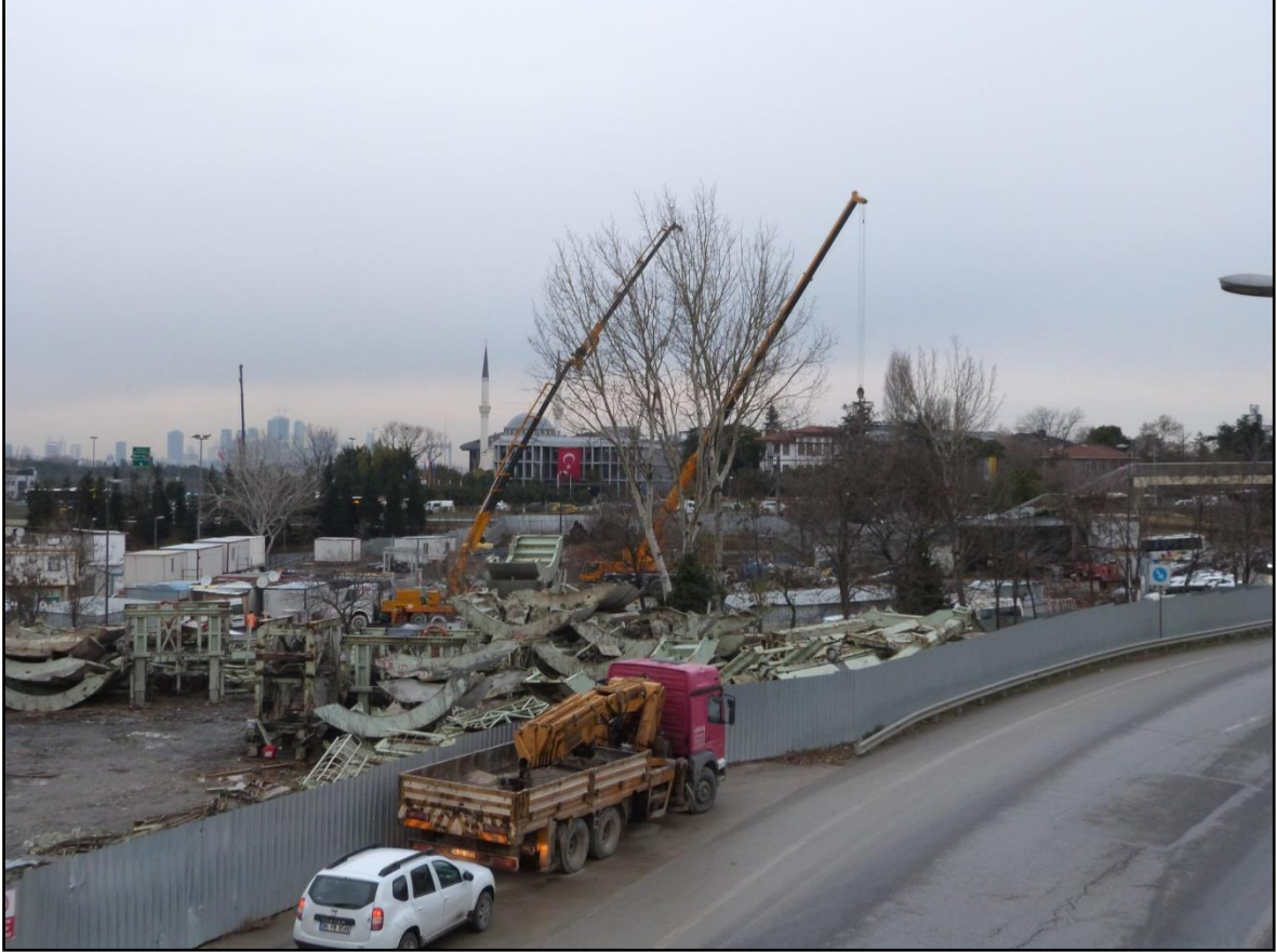
Şekil II.A.2 Altunizade İstasyonunun Planlandığı Alandan Görünüm
