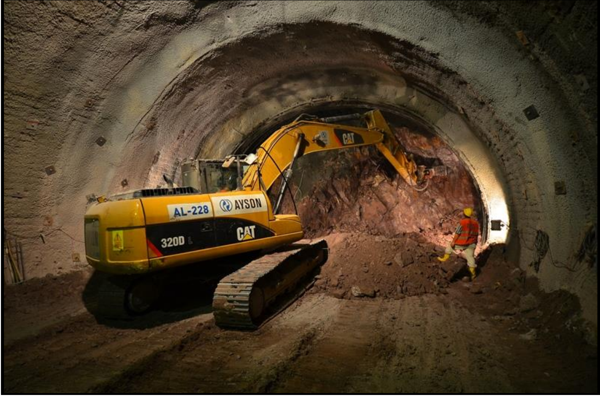
Şekil I.B.1.2 NATM Tekniği İle Açılan Üsküdar-Ümraniye-Çekmeköy Metrosu Tüneli
