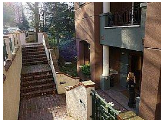
Site içi yoldan binaya arka giriş
