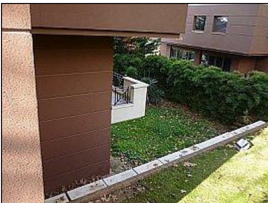
Arka cepheden binaya bakış- bahçe kısmı
