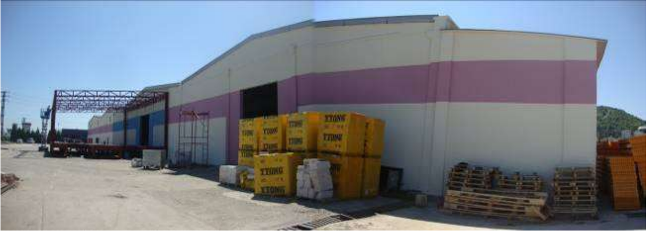
AK-AL 4 (AK-KİM depo binası)
