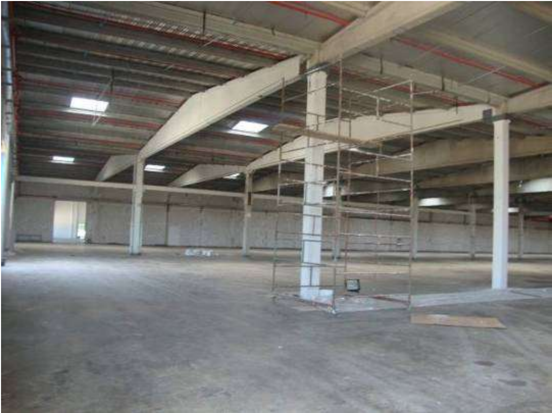
AK-AL 4 (AK-KİM depo binası)
