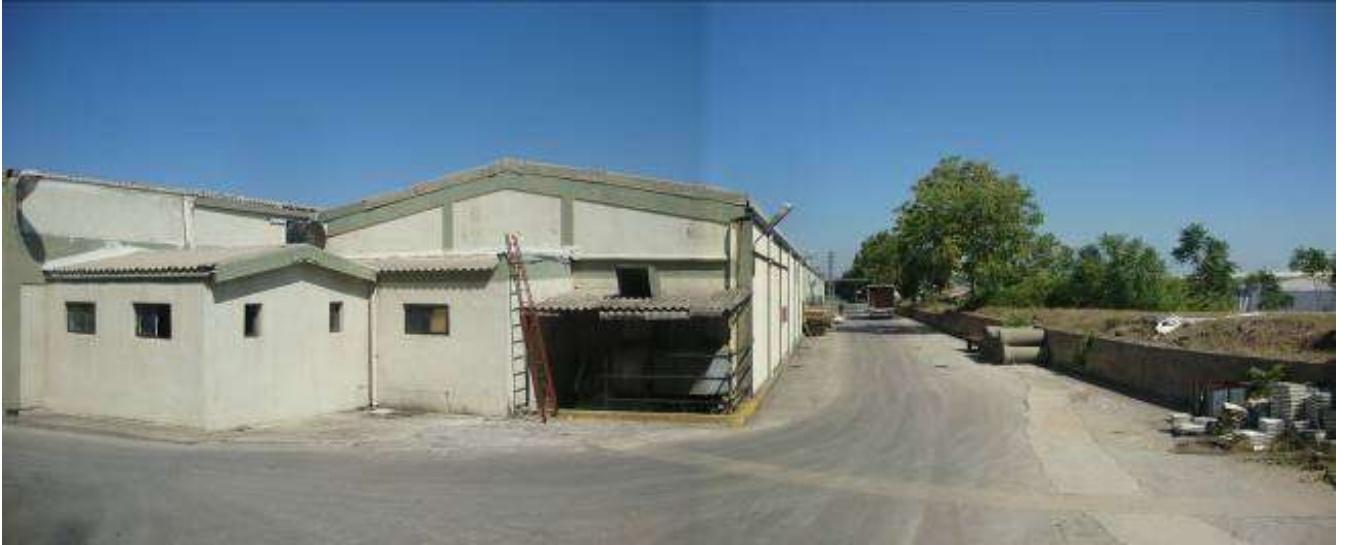
Tesis bünyesindeki binalar
